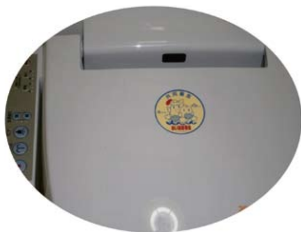
3ホーム4ヶ所のトイレを整備しまし
